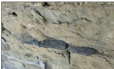
*Schieferstücke als Versetzhilfe bei der Ausrichtung der Steine*
